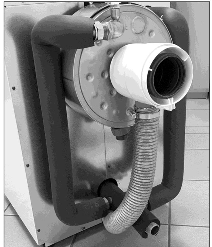
Abb. 16: Montierter Anschluss DN 80/125
