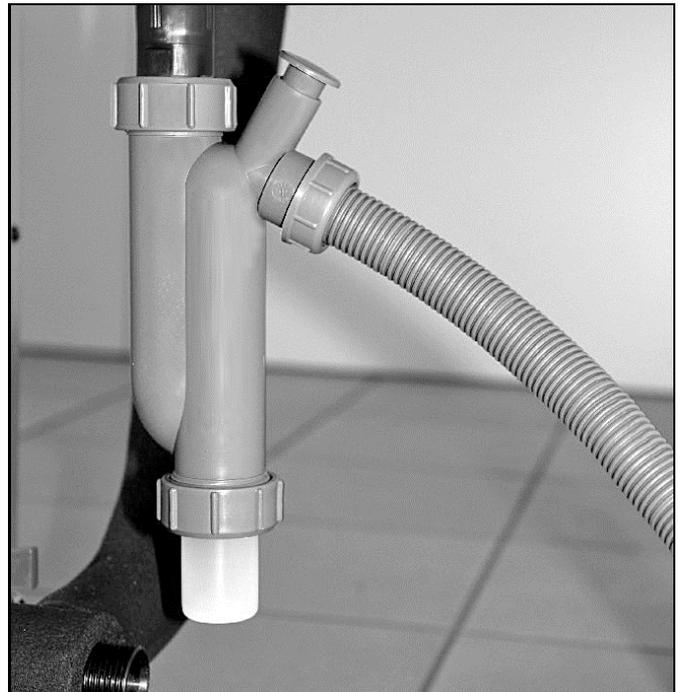
Abb. 76: Siphon und Kondensatschlauch
