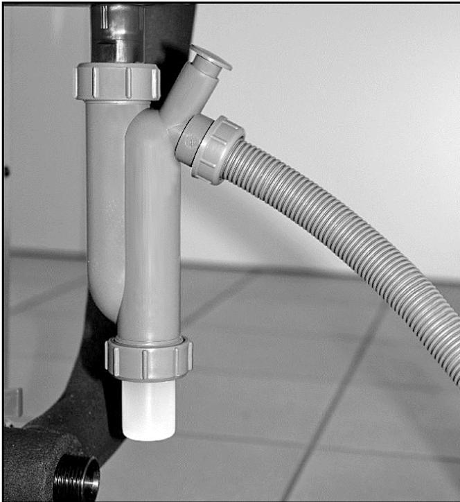
Abb. 25: Montierter Kondensatschlauch am Siphon
