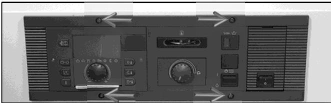
Abb. 31: Befestigungsschrauben des Kesselschaltfeldes
