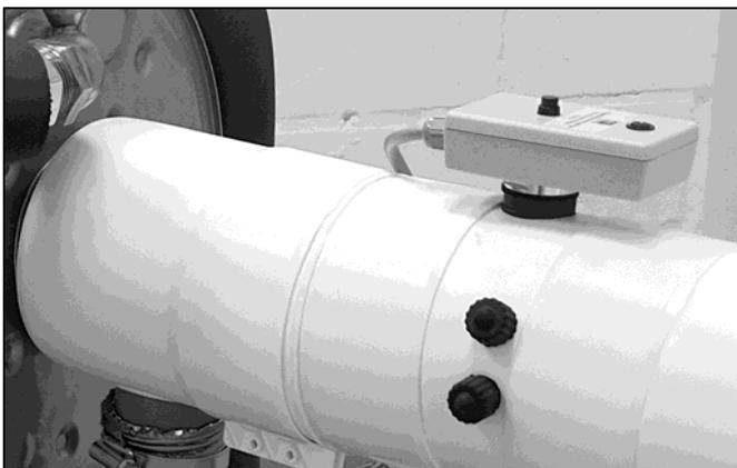
Abb. 85: Position des ATB DN 80/125 (geschraubt)
