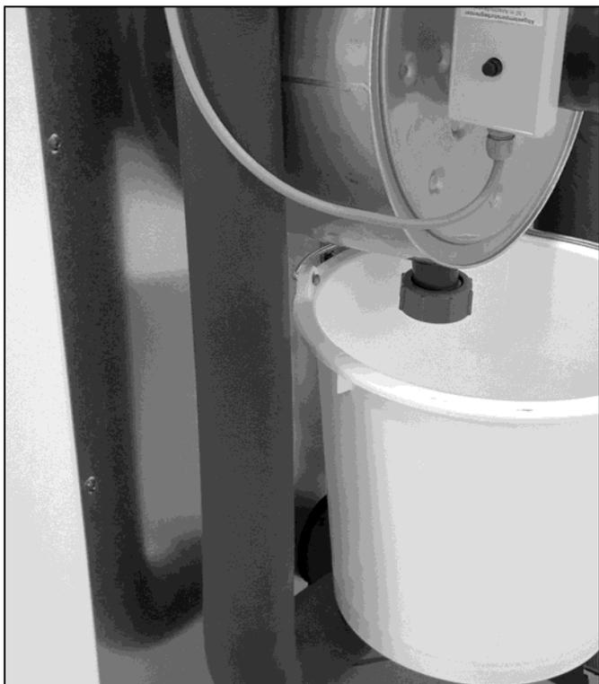
Abb. 81: Eimer unter dem Siphon-Anschluss des Abgaswärmetauschers
