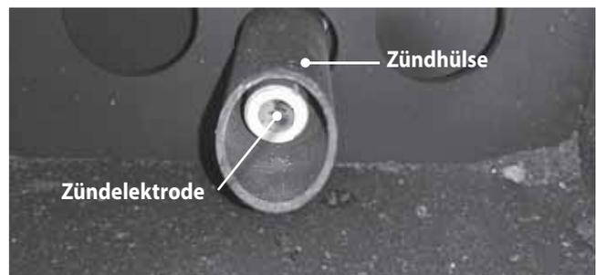
Dabei wird die in die Zündhülse einströmende Luft stark erhitzt. Diese stark erhitzte Luft strömt aus der Zündhülse in die **Brennerschale (5)** und entzündet die darin befindlichen Pellets.
