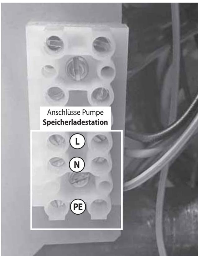
Bei der Verlegung des Steuerkabels vom Gerät zur **Speicherladestation** ist das Steuerkabel durch die dafür vorgesehene **Durchführung externer Schaltkontakt (35)** im Bereich des **Netzschalters (19)** zu führen und die Zugentlastung ordnungsgemäß zu montieren.
