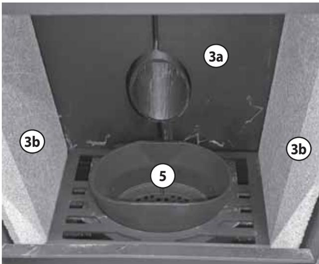
Anschließend werden die **linke** und **rechte seitliche Brennraumverkleidung (3b)** entnommen.
