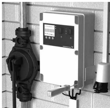
Abb. 8 Anbringen der Steuerung LC 221
