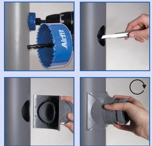
Einfache Installation: Loch bohren (rechtwinklig zur Rohrachse) Ø 57 mm, entgraten, Schneidöl entfernen, Schraub-Abzweig aufsetzen und anziehen. FERTIG!
