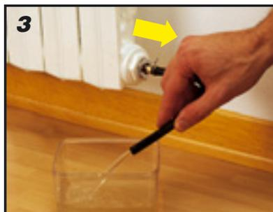
**3** Am Schlauch ziehen und das ausfließenden Wasser in einem Behälter sammeln.
