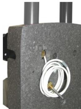
5. - Vorlauf-Fühlerkabel in die eigens dazu bestimmte Öffnung in der Mitte der Isolierschale hineingeben um es bei dem entsprechenden 3-Wege Vorlaufkugelhahn anschließen zu können.
