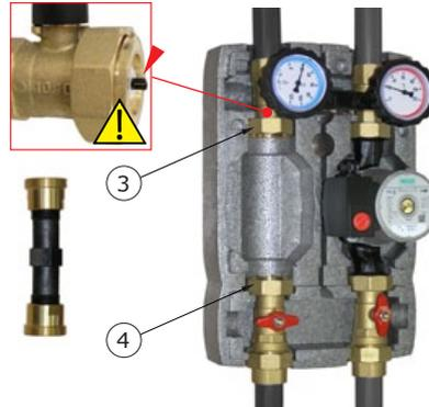
2. - Überwurfmutter ③ und ④ aufschrauben und das Distanz-Rohr mit Übergängen abnehmen. Dies wird vereinfacht, wenn die hintere Isolierung abgenommen wird.
