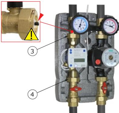
4. - Den Wärmehähler einbauen und die Überwurfmutter ③ und ④ festschrauben. Das Fühlerkabel des Rücklaufes kann hinter den Wärmehähler aufgewickelt werden.
