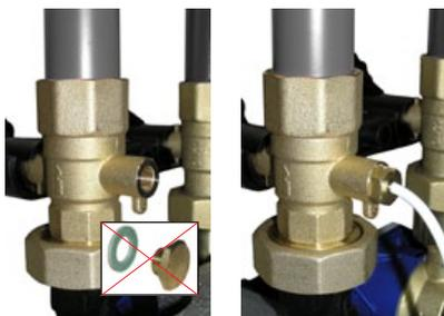
7. - Kappe und Dichtung des 3-Wege-Kugelhahns entfernen und Fühler mit eigener Stopfbüchse und O-Ring in Tauchhülse einführen. Dies wird vereinfacht, wenn die hintere Isolierung abgenommen wird.
