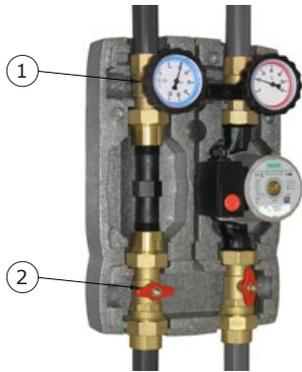
1. - Kugelhahn ① und ② bei Rücklauf vor und nach dem Kunststoff-Distanz-Rohr schließen.
