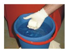
1. Verpackung öffnen und Bandage 2. Rohr ist drucklos und kalt. Repaca. 30 Sek in Wasser (Temp. Ca. 20 raturstelle ist sauber u. feucht. °C) tauchen. Bandage leicht durch- Bandage zügig u. straff umwickeln kneten
