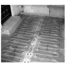
Zum Fixieren der Rückleitungen haben die Dübel Einbuchtungen im Kopf, mit welchen Sie das Rohr direkt greifen können.
