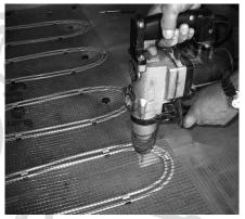
Zum Fixieren jeweils im Kreismittelpunkt eines Schleifenbogens ein Loch mit 6 mm ø bohren und einen Niederhaltedübel einschlagen, zwischendurch die Matte immer wieder glatt ziehen.
