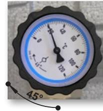
Zur Befüllung oder Entleerung des Heizkreises muss das Rückschlagventil umgangen werden, indem das Stellrad mit blauem Thermometer um 45° im Uhrzeigersinn gedreht wird, ausgehend von der komplett geöffneten Position (siehe Foto links).
