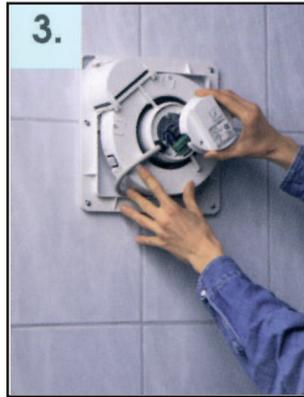
**Bild 11:** Aufstecken der VENTO.TRONIK®
