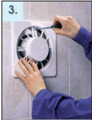
Bild 5: Montage des Filterträgers
