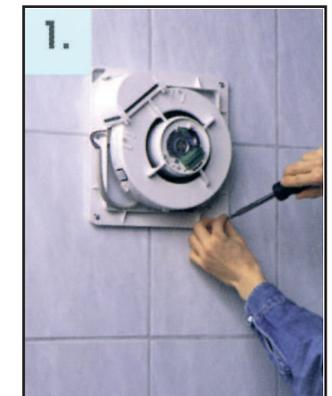
**Bild 9:** Montage der Grundplatte über der Abluftöffnung
