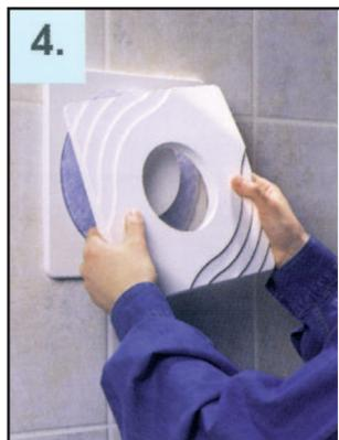
Bild 6: Aufstecken der Lüfterfassade
