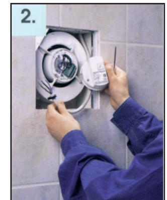
**Bild 4:** Elektro-Anschluss der VENTO.TRONIK®
