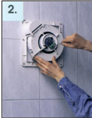
**Bild 10:** Elektroanschluss der VENTO.TRONIK®
