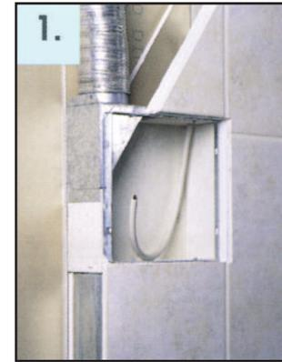
**Bild 3:** Typ U in Trockenbauwand
