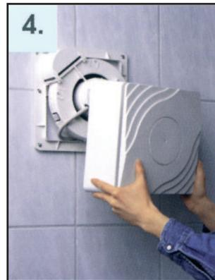
**Bild 12:** Aufstecken der Lüfterabdeckung
