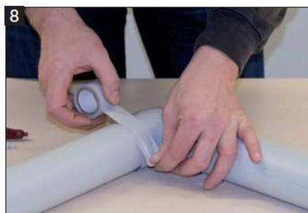
8 Stoßstellen mit PVC Klebeband verkleben
