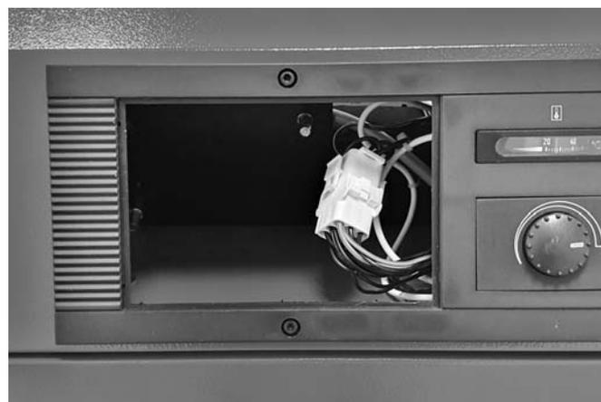
Abb. 29: Offener Reglerschacht mit Steckverbindung für den Regler-Kabelbaum.
