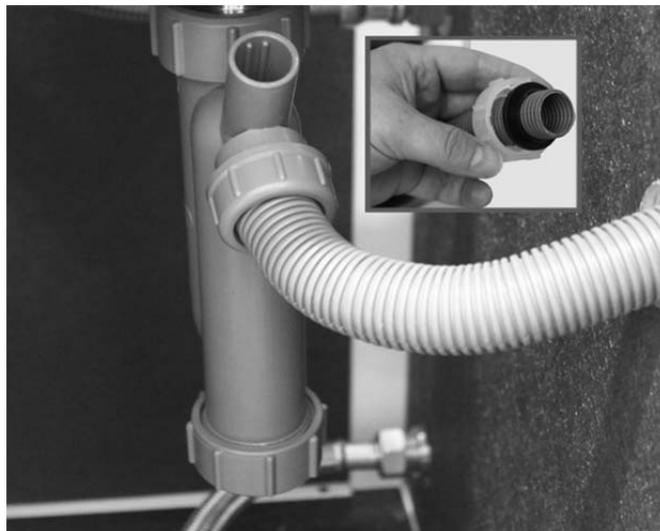
Abb. 16: Montage des Kondensatschlauchs
