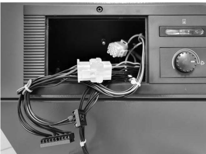
Abb. 33: Anschlussstecker für den Regler.
