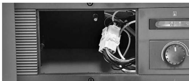
Abb. 105: Aufgesteckter Brückenstecker.
