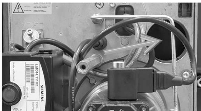
Abb. 9: Luft-Ansaugöffnung des Blau-Brenners BNR
