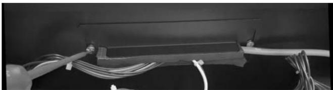
Abb. 32: Verschlossener Kabelschlitz.
