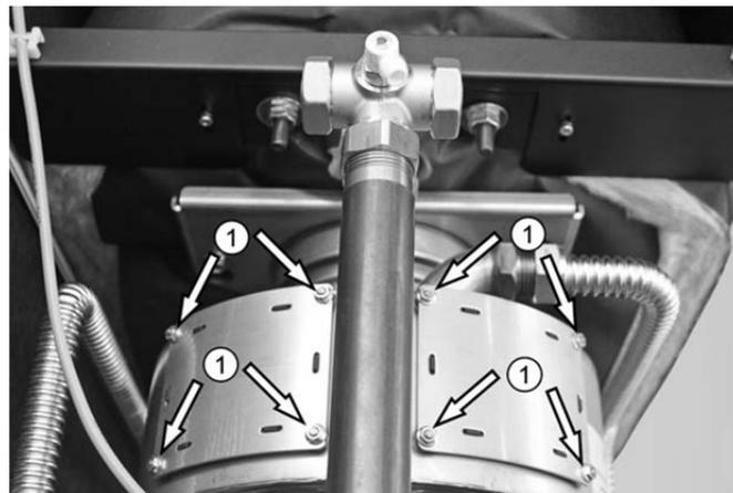
Abb. 87: Muttern ① der Reinigungsabdeckungen vom RWT
