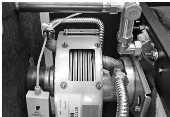
Abb. 88: Reinigungsöffnung des RWT
