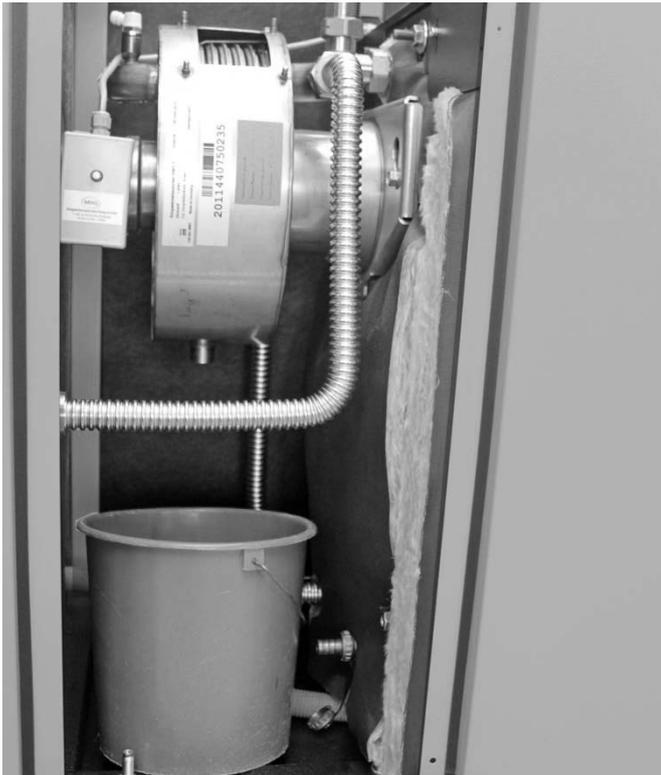
Abb. 89: Zur Reinigung vorbereiteter RWT
