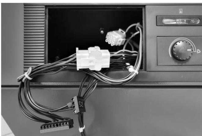
Abb. 104: Getrennte Anschlussstecker für den Regler.
