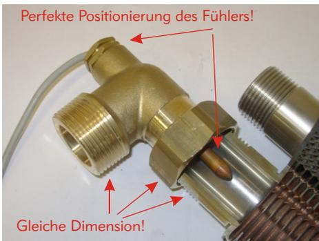
Perfekte Positionierung des Fühlers!
